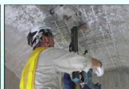
(2) \phi 10\text{mm} のコア削孔
