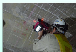
(1) 鉄筋探査
