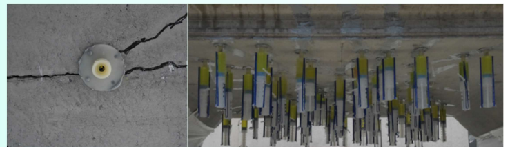
(3) 樹脂注入器具設置
