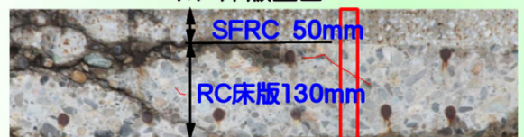
旧銚子大橋の撤去RC床版
