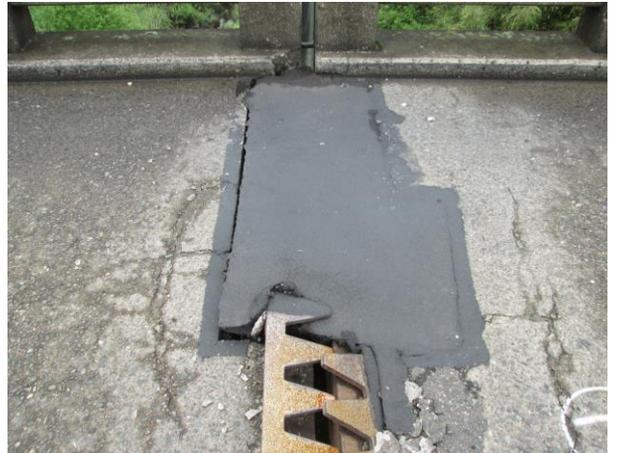
平成28年熊本地震後、MMジョイントDS型と鋼製ジョイントとの損傷の比較が可能な施工箇所があった。写真1は鋼製ジョイントの一部をMMジョイントDS型で補修を行った当時の状況である。写真2は熊本地震後であり、鋼製ジョイントは大きな被害を受けているが、MMジョイントDS型は舗装との界面で一部剥離が見られるものの、特殊合材は弾性体であることから大きな被害が無く、応急処置で復旧が可能となる。よって地震による変形やねじれにも対応できる結果となった。
