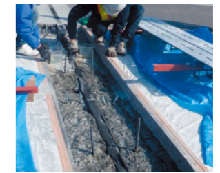
写真2-1. 浸透性KSプライマー塗布
