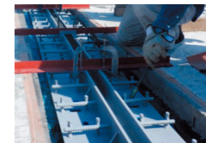
写真2-3. 鉄筋配置・KSボンド塗布
