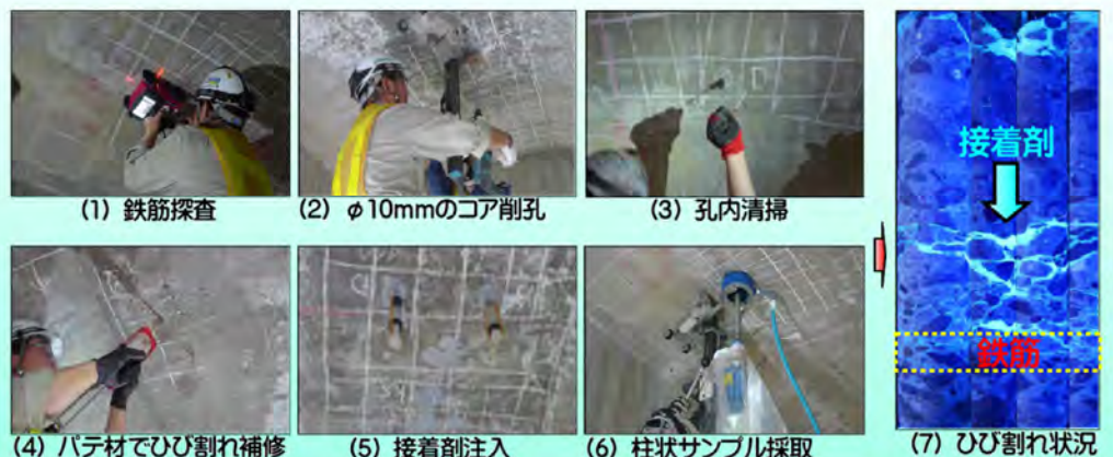
RC床版下面からの柱状サンプル採取法
