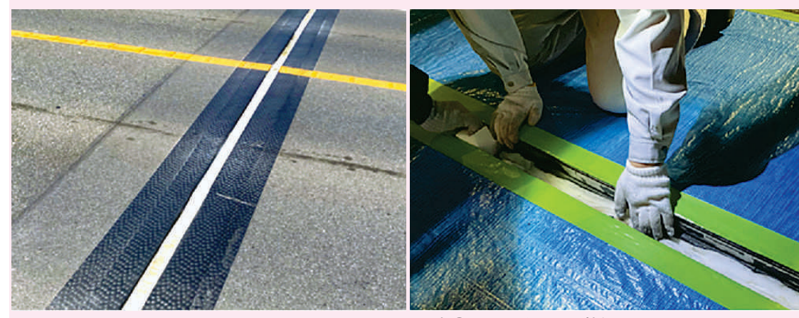
写真② 撤去後、施工部分の清掃 接着面の下地が荒れている場合は、研磨ブラシなどを使って下地調整を行う。海浜地区など施工箇所には塩分がある場合は、接着面の水洗いを十分に行う。
