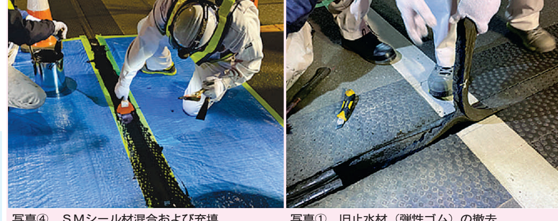
写真④ SMシール材混合および充填 SMシール材と硬化剤を混合攪拌し、その後添加剤を加え十分に攪拌する。容器を傾けても材料が流れないことを確認してから充填を行い、ヘラ・コテなどで平滑に仕上げる。
