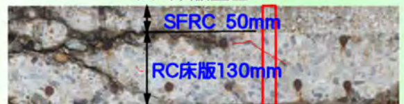
旧銚子大橋の撤去RC床版
