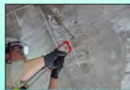
(4) パテ材でひび割れ補修
