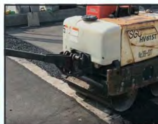
3) 特殊合材(2層目) ・転圧作業
