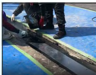
1) バインダー塗布 ・プレート設置
