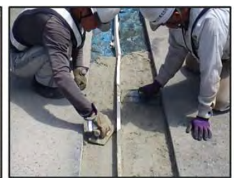
4) リフレモルタルSF打設
