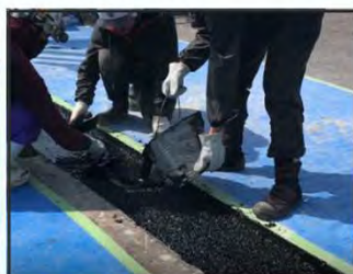
2) 特殊合材打込み ・バインダー塗布
