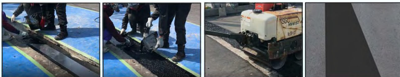
1) バインダー塗布・プレート設置
