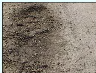
(2)コンクリートの土砂化
