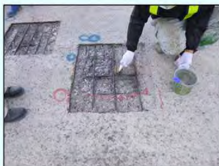
(5)浸透性KSプライマー塗布
