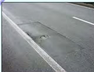
(1)ポットホールの発生
