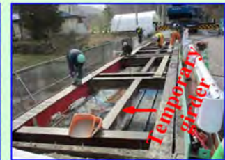
(4) ジベル筋の取付け
