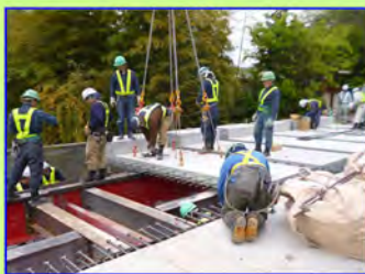
(1) 取替RC床版設置
