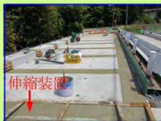
(7) 伸縮装置設置
