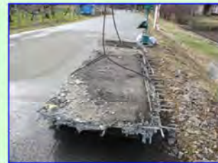
(3) 撤去後の床版
