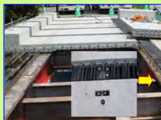
(2) 間詰部の鉄筋配置
