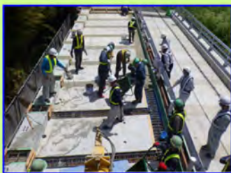
(5) 間詰部コンクリート打設
