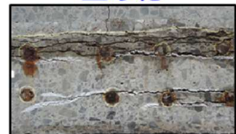
水平ひび割れ
