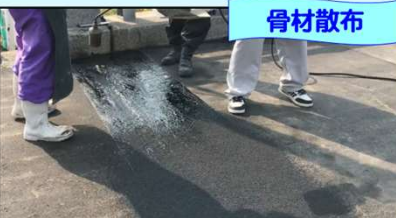
MMジョイントDS施工手順
