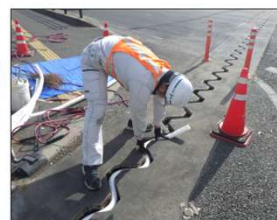
(3) バックアップ材挿入
