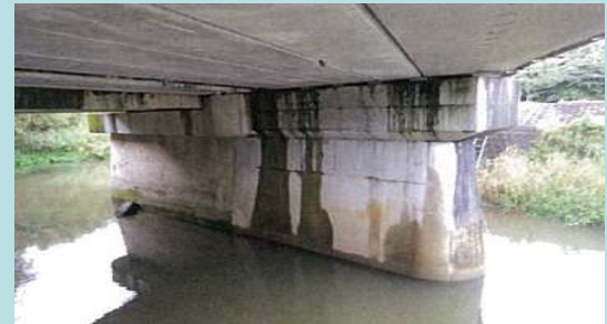
遊間部からの漏水状況
