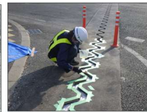
(4) プライマー塗布
