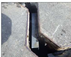
(1) 遊間部の損傷
