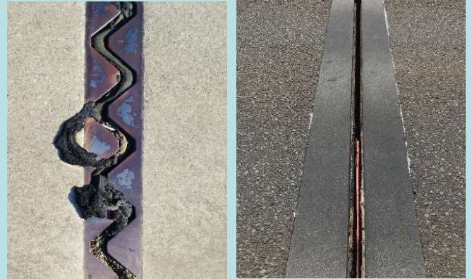
遊間部のゴム劣化の状況
