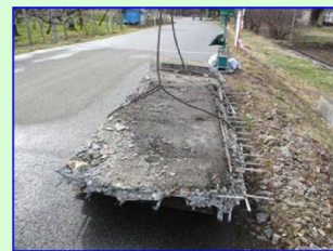
(3) 撤去後の床版
