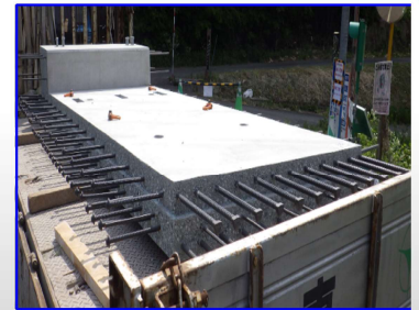
(2) プレキャスト床版輸送 取替RC床版のプレキャスト床版製作
