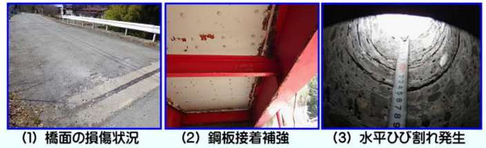
(1) 橋面の損傷状況 (2) 鋼板接着補強 (3) 水平ひび割れ発生
