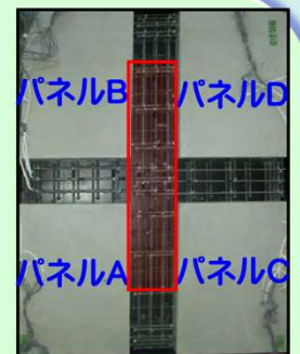
取替RC床版B
