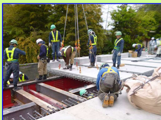
(1) 取替RC床版設置
