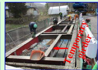
(4) ジベル筋の取付け
