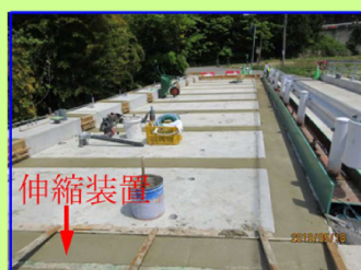
(7) 伸縮装置設置
