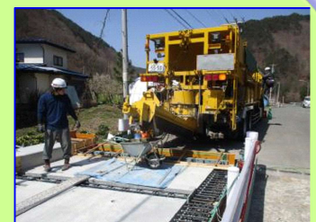
(4) 移動プラントで練混ぜ
