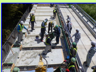
(5) 間詰部コンクリート打設
