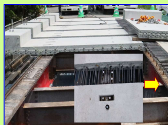
(2) 間詰部の鉄筋配置
