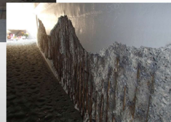
ボックスカルバートの損傷
