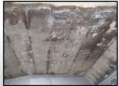
ボックスカルバート頂版の損傷
