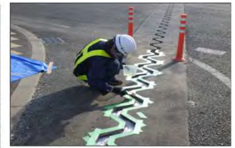
(4) プライマー塗布
