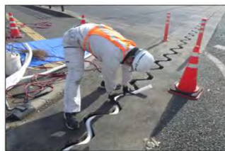
(3) バックアップ材挿入
