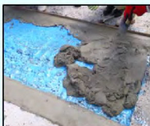
(6) モルタル打ち込み
