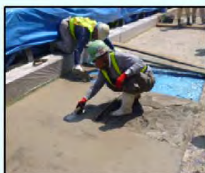
(7) 部分補修による表面仕上げ
