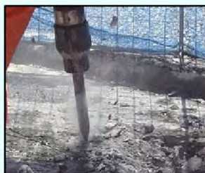
(2) アスファルト舗装撤去
