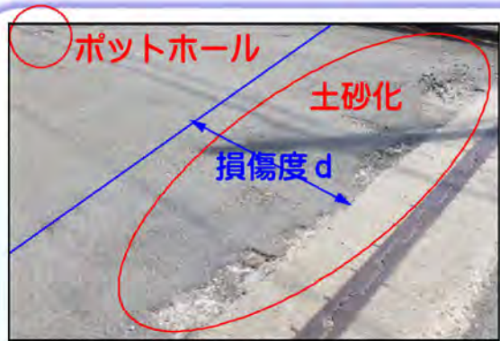
ジョイント付近の損傷事例
