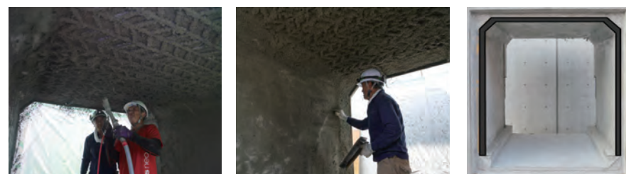
(4) PCM吹付け (5) コテ仕上げ (6) 完成
