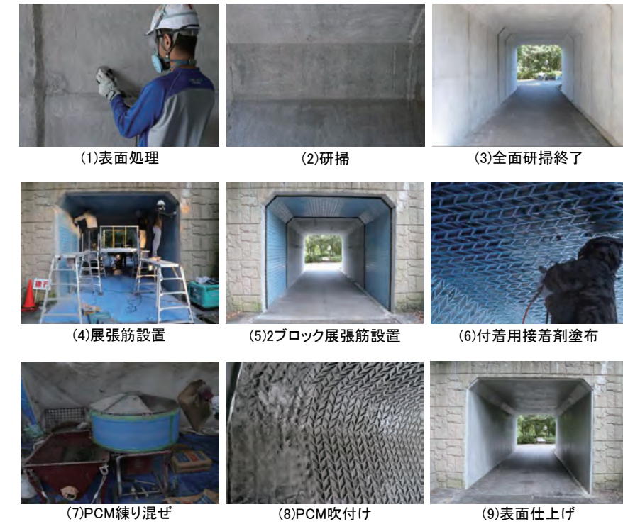
写真8 カルバートの施工手順
