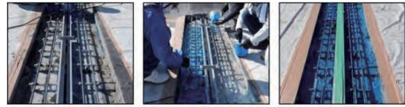
(1) 伸縮装置の設置 (2) 付着用接着剤塗布 (3) 付着用接着剤塗布完了
