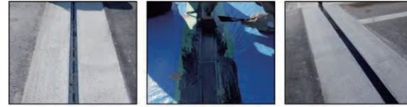
(1) ほうき仕上げ (2) SM止水材を充填 (3) 伸縮装置完成
