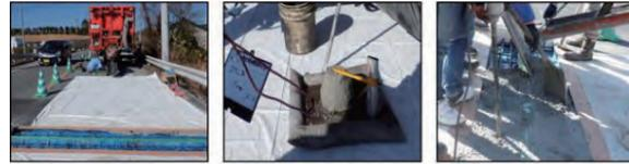
(1) 移動式プラント (2) スランプ試験 (3) 超速硬コンクリート打ち込み
