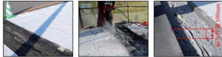
写真4 伸縮装置の撤去作業およびはつり作業
