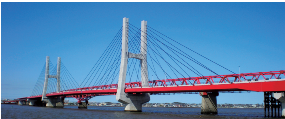
写真-4 初代銚子大トラス橋・2代目橋斜張橋(旧銚子大橋撤去前)
