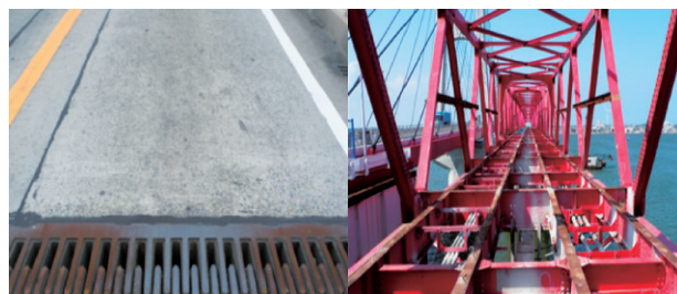
写真-8 撤去時のRC床版およびトラス構造
