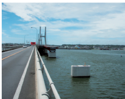
写真-5 斜張橋・橋脚の完成
