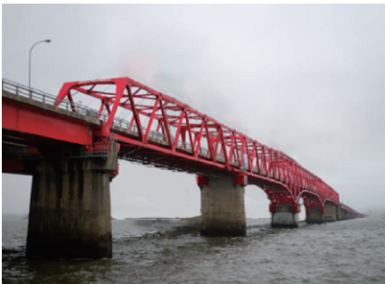
写真-1 初代銚子大橋
