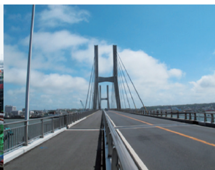
写真-7 2代目銚子大橋完成
