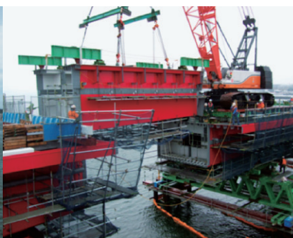
写真-6 鋼げたの設置
